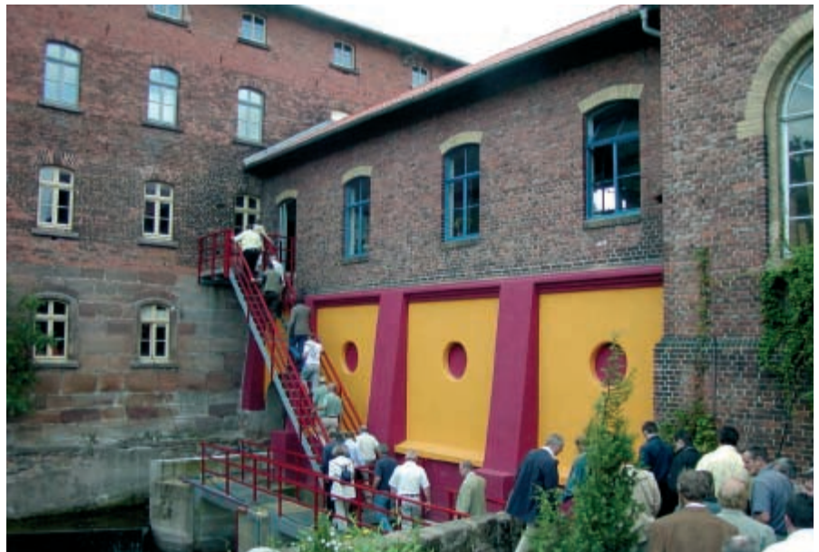
Mehr als 70 Personen kamen auf Einladung der SPD-Fraktion nach Jägersdorf bei Jena, um das dortige Wasserkraftwerk - ein architektonisches Kleinod - zu besichtigen.
