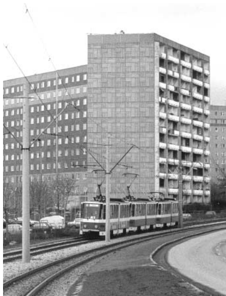
Immer mehr Wohnungen in Neubauten stehen leer. Der Freistaat kommt künftig nicht umhin, den Abriss von Gebäuden finanziell zu unterstützen.
